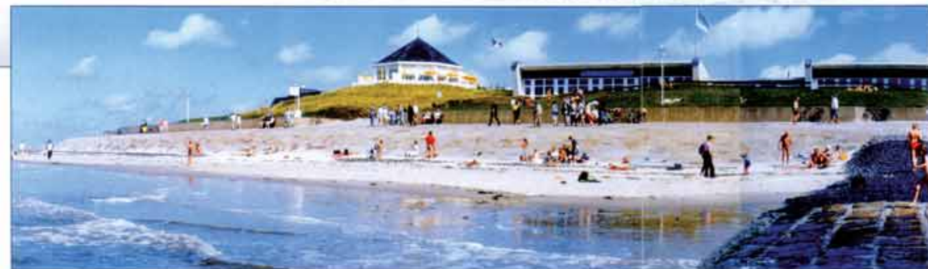
Abb. 2: Panorama mit bestehender steiler Flutmauer
