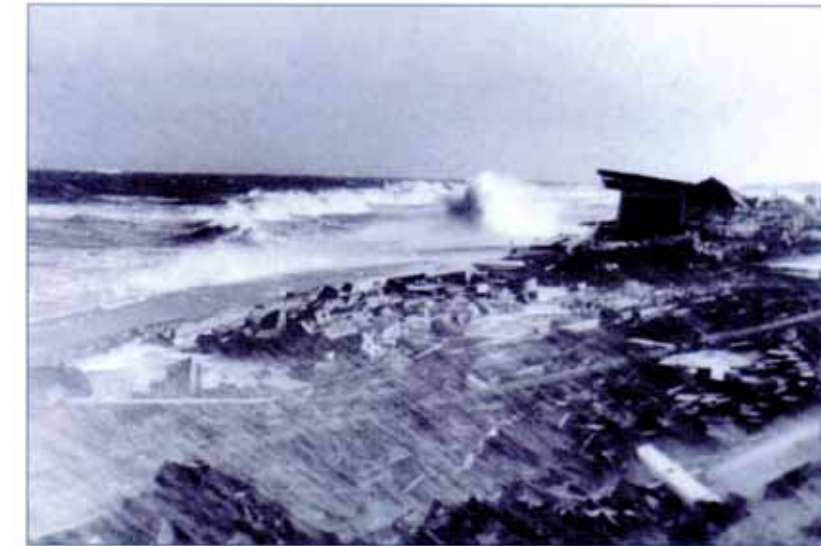
Abb. 3: Schwere Zerstörung nach der Sturmflut vom 16.02.1962
