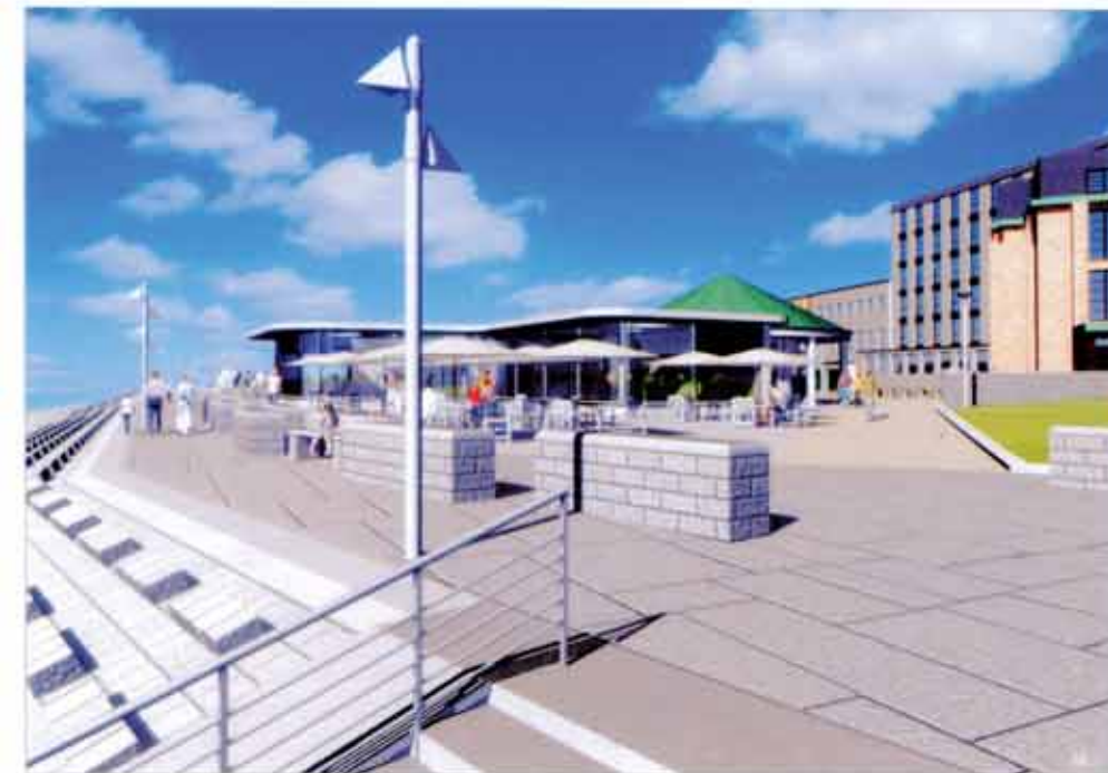
Abb. 6: Schwallwände / obere Promenade und Rauhdeckwerk an der Milchbar
