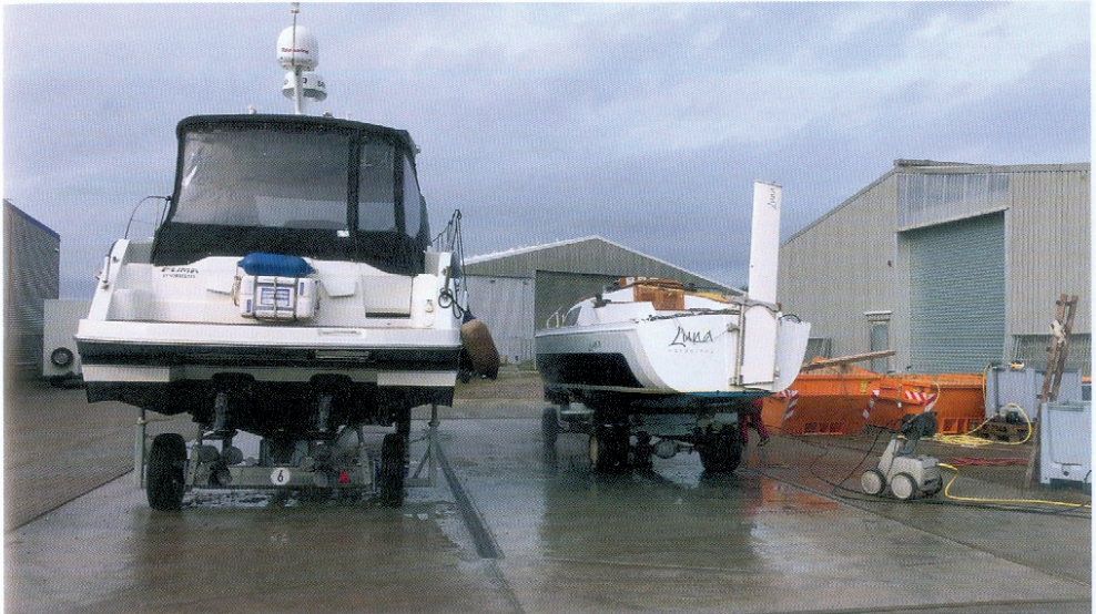
Waschplatz vor Halle C mit Abflussrinne, unterirdischer Auffanggrube, temporären oberirdischen Sammelcontainern zur Vorbehandlung und grauen Boxen für die Filter.
